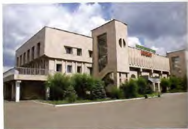
89. Экибастуз. Новый железнодорожный вокзал. Фото 2008 г.
