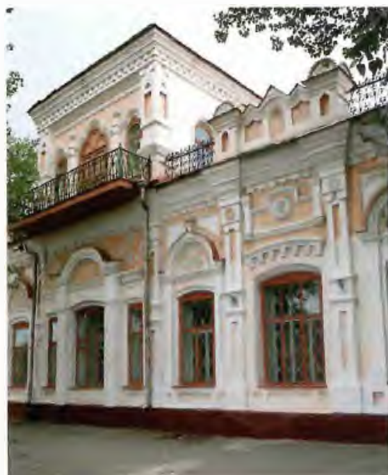
Торговый дом Дерова. Главный фасад. Фрагмент с мезонином. Фото 2007 г.
