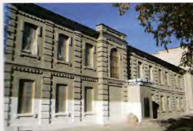
Больница уездная. Главный фасад. Фото 2007 г.
