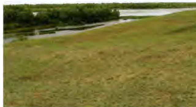
14. Стоянка Тилектес. Вид с юго-востока
