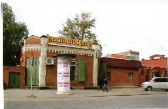
41. Магазины Кошелева. Главный фасад. Фото 2007 г.
