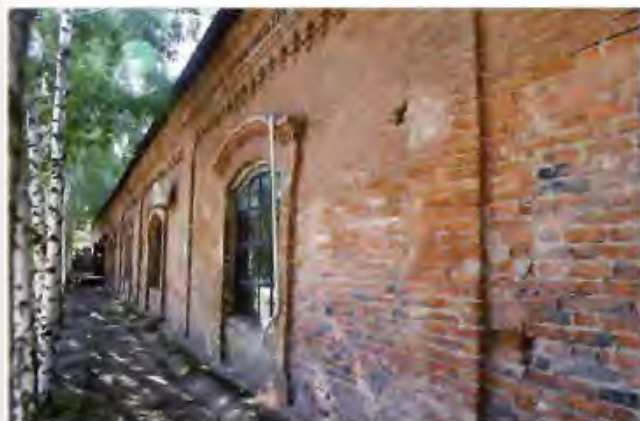
Магазины Кошелева. Фрагмент южного фасада. Фото 2008 г.
