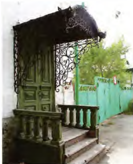
37 Дом Сорокина с флигелем. Главный фасад. Крыльцо. Фото 2007 г.
