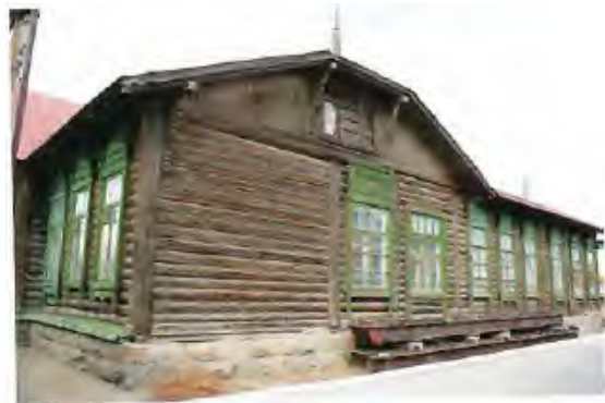
66. Школа водников. Южный фасад. Фото 2007 г.
