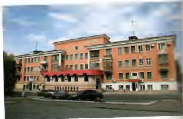
21. Дом жилой 16-квартирный. Главный фасад. Фото 2007 г.
