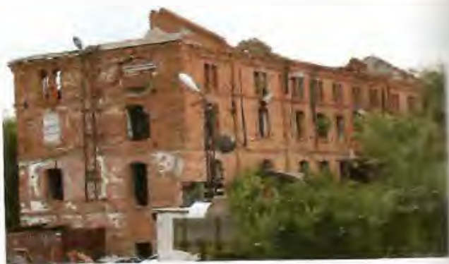
45 Мельница Тиссена. Общий вид. Фото 2008 г.
