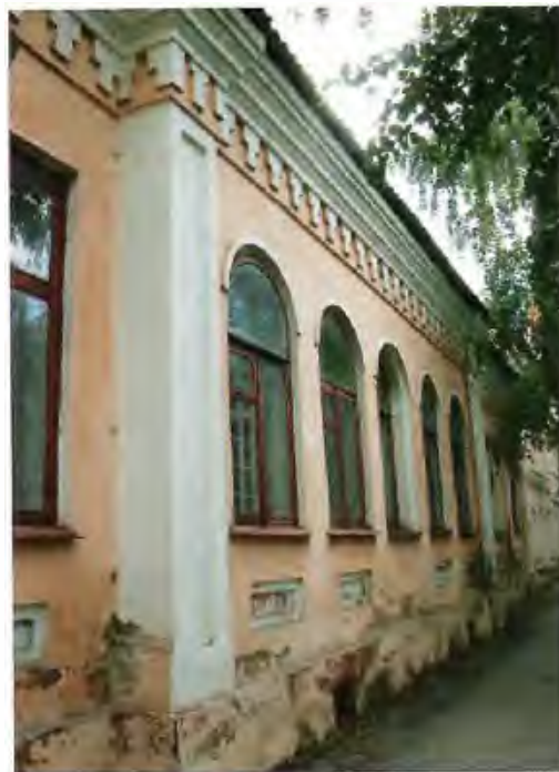
5. Банк общественный. Фрагмент главного фасада. Фото 2008 г.
