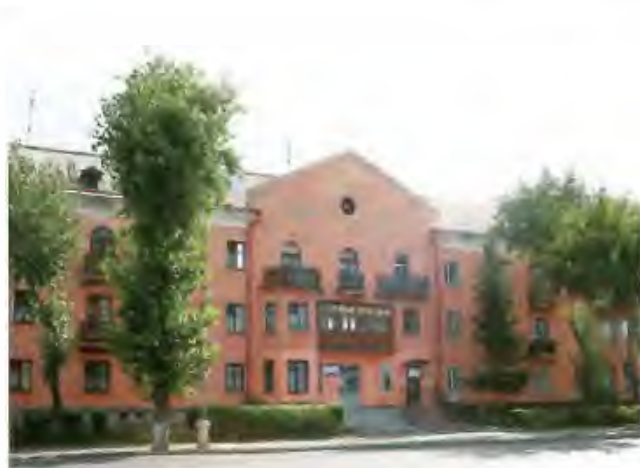
22 Дом жилой 24-квартирный. Главный фасад. Фото 2007 г.
