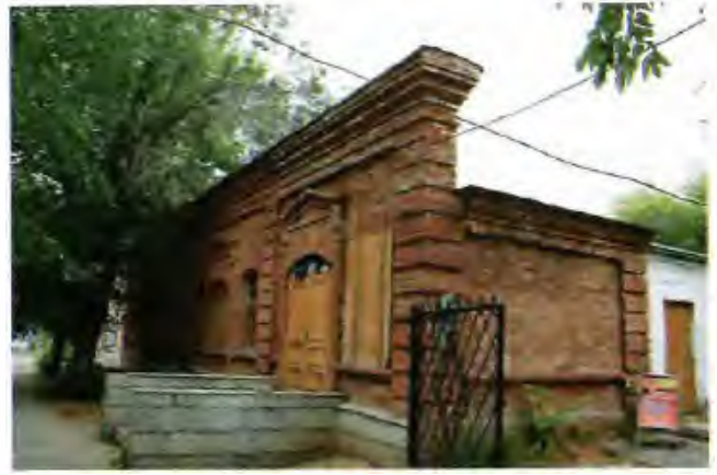
15 Депо пожарное. Общий вид. Фото 2008 г.
