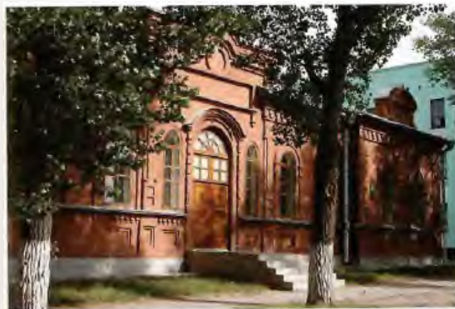
64. Училище Владимирское. Главный фасад. Фото 2007 г.
