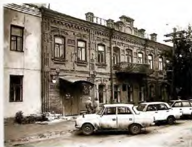
Контора почтово-телеграфная. Главный фасад. Фото 1975 г.
