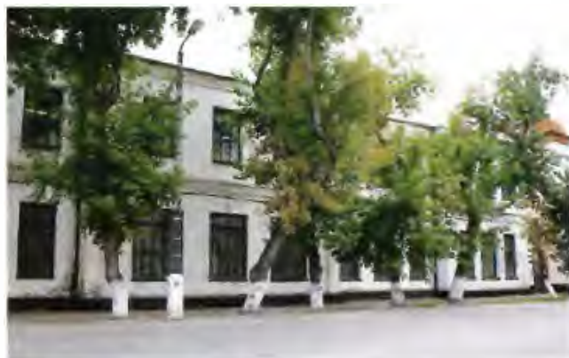
42. Магазины Сарокина. Главный фасад. Фото 2007 г.
