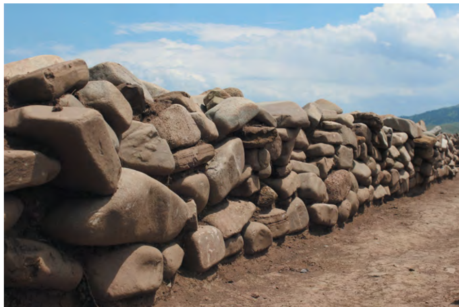
Рис. 37. ППКК. Каменное кольцо. Внешний фасад
