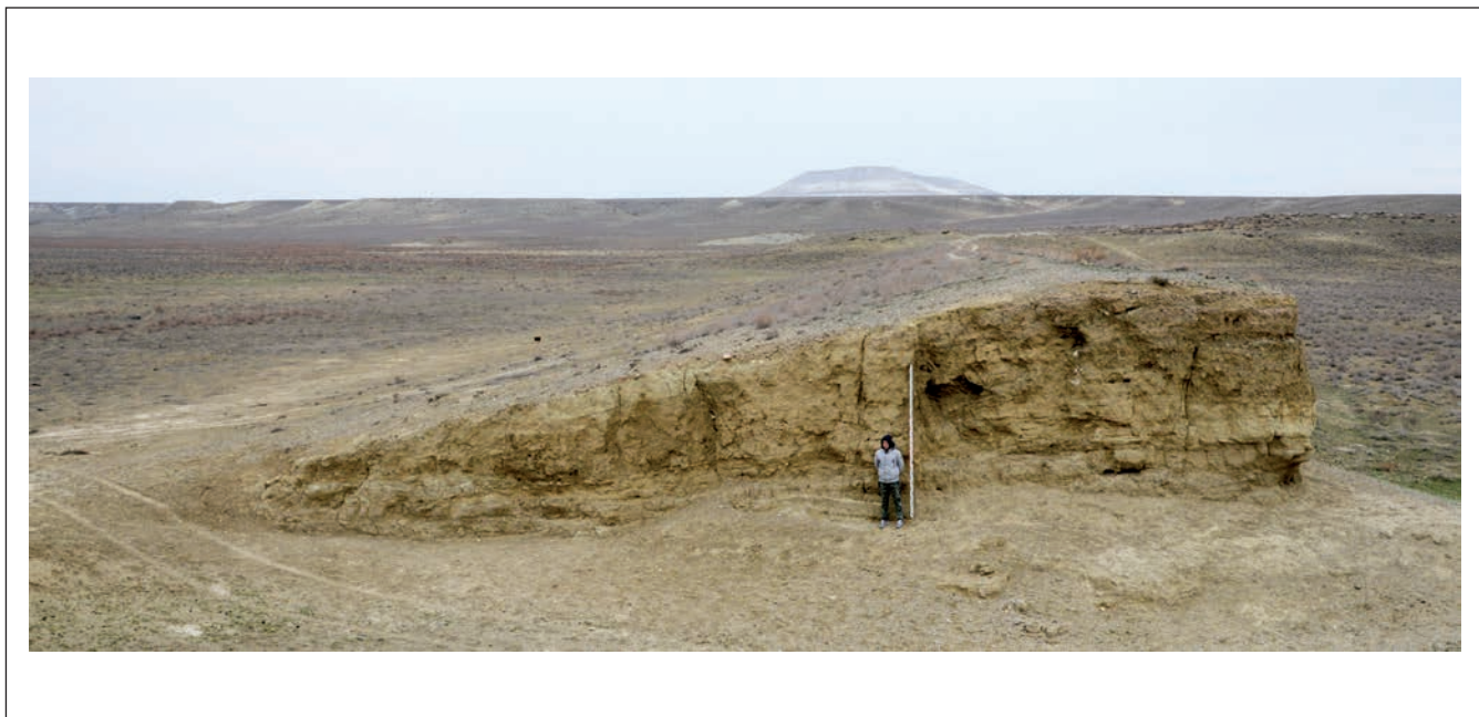
Рис. 7. Сечение насыпи плотины у горы Шеркала.
